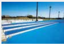
5 傾斜走路(陸上競技場内)
